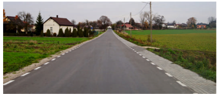
Przebudowa ul. Dolnej w Dąbrowie Zielona
